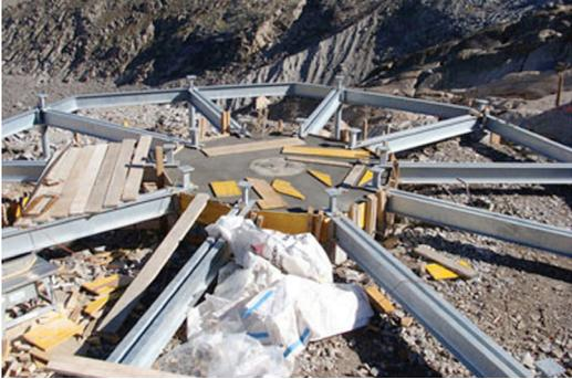
Abb. 44: Stahlplattform mit Betonkern
