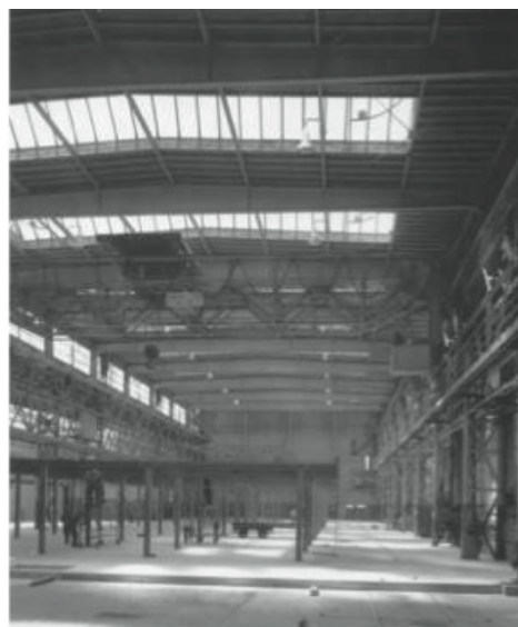
Abb.40: Sulzerhalle 180 vor bzw. während dem Umbau. Das Grundgerüst für die Räumlichkeiten entsteht gerade.
