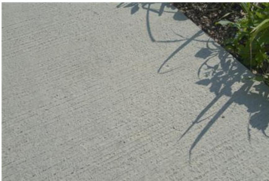
Der Gehweg wird betoniert und die Oberfläche in "Besenstrichoptik" ausgeführt. Diese Ausführung dient einerseits als Rutsch-Schutz für Fußgänger bei nassem Wetter und andererseits zur deutlichen Abhebung vom Straßenraum für die Fahrzeuge.
