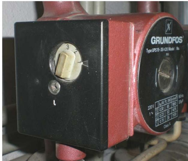
Abbildung 12: Ungeregelte Pumpe mit Asynchronmotor.
