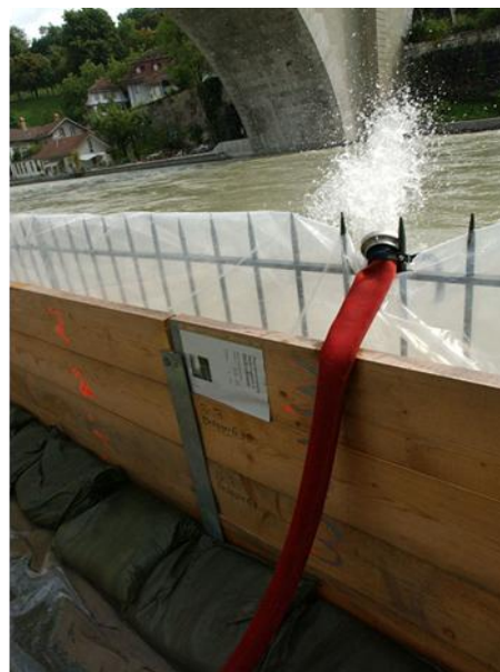
Abbildung 59: Tafelsystem als Ufersicherung (Egli, 2004)
