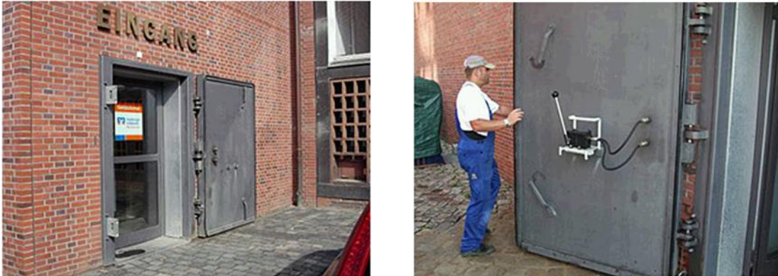
Abbildung 36: Hubschwenktor in geöffnetem Zustand (links), hydraulische Handpumpe für das Anheben der massiven Tür (rechts) ( www.hochwasserschutz.de , Zugriff am 10.8.2012)
