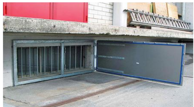
Abbildung 35: Schwenktor zur Sicherung einer Abfahrt (links) und zur Sicherung einer Gebäudeöffnung (rechts) (www.whs-hochwasserschutz.de, Zugriff am 20.9.2012)
