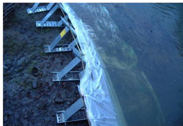
Abbildung 61: Stellwandsystem aus Aluprofilen (www.rs-stepanek.de, Zugriff am 20.9.2012)
