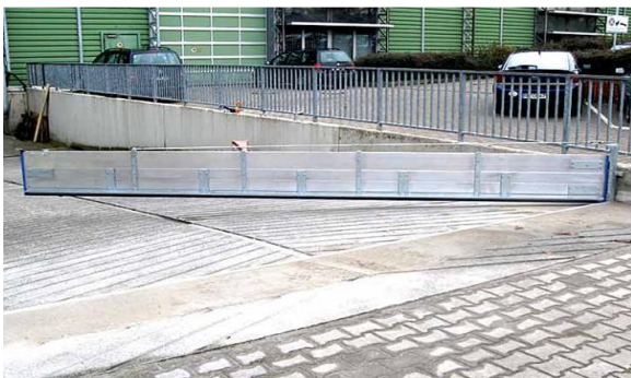
Abbildung 35: Schwenktor zur Sicherung einer Abfahrt (links) und zur Sicherung einer Gebäudeöffnung (rechts) (www.whs-hochwasserschutz.de, Zugriff am 20.9.2012)
