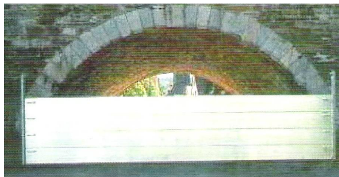
Abbildung 81: Dammbalken vor einer denkmalgeschützten Mauer (BWK, 2005)
