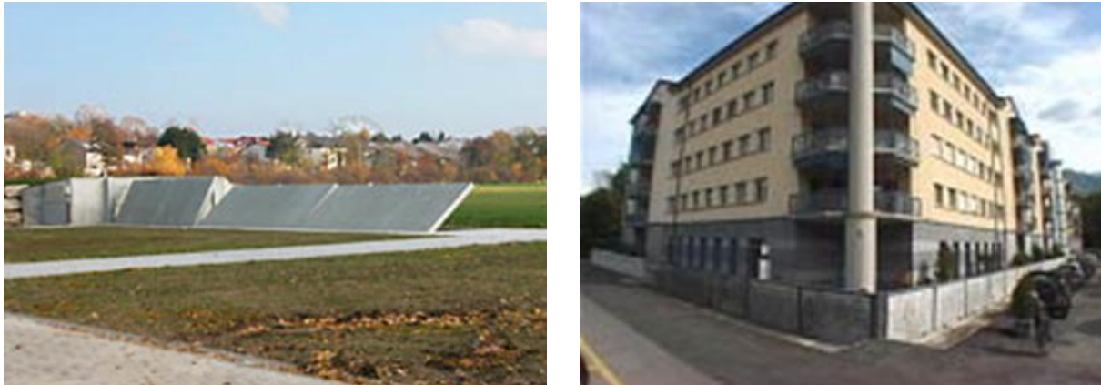
Abbildung 42: Klappbare Elemente werden maschinell angehoben (links), Gebäudeschutz auf Gehsteigniveau (rechts) ( www.HWS - technologie.de , Zugriff am 20.9.2012)
