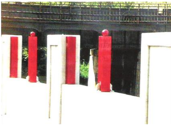
Abbildung 83: Farblich gestaltete Abdeckbleche für ein Dammbalkensystem (links), mittels Abdeckblech verdeckte C-Profile (Andritz) (BWK, 2005)
