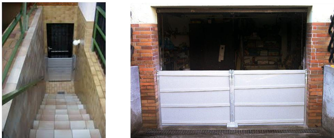
Abbildung 29: Dambalkensystem bei Stiegenabgang (links) und als Schutz für eine Garagenöffnung (rechts) (www.hochwasserschutz.de, Zugriff am 20.9.2012)
