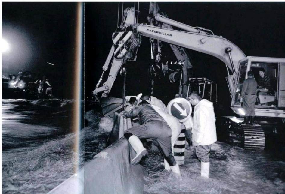
Abbildung 56: Aufbau eines Betonelementsystems mittels Raupenbagger (Egli, 2004)
