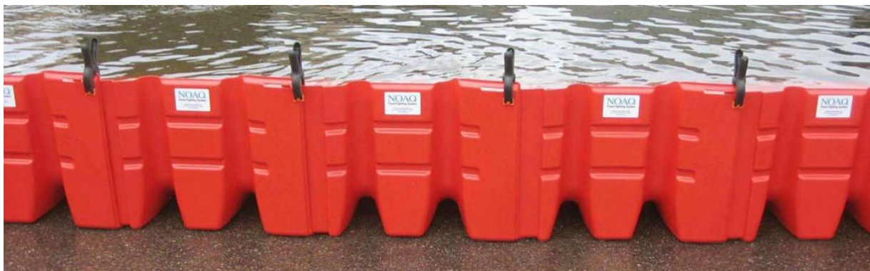
Abbildung 64: NOAQ Boxwall im Einsatzzustand ( www.awma.au.com , Zugriff am 1.10.2012)
