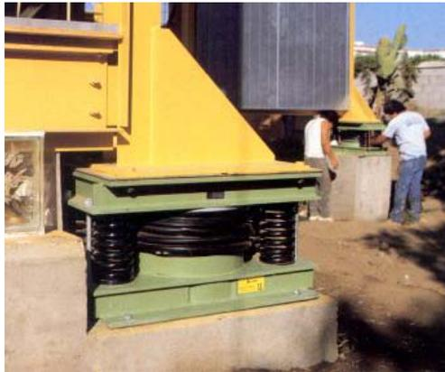
Abbildung 4-9: Stahlfederelemente unter einer Stahlstütze [83]
