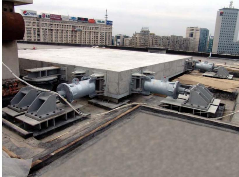
Abbildung 4-13: Installation eines Tilgers auf dem Dach des Palatul Viktoria in Bukarest [87]
