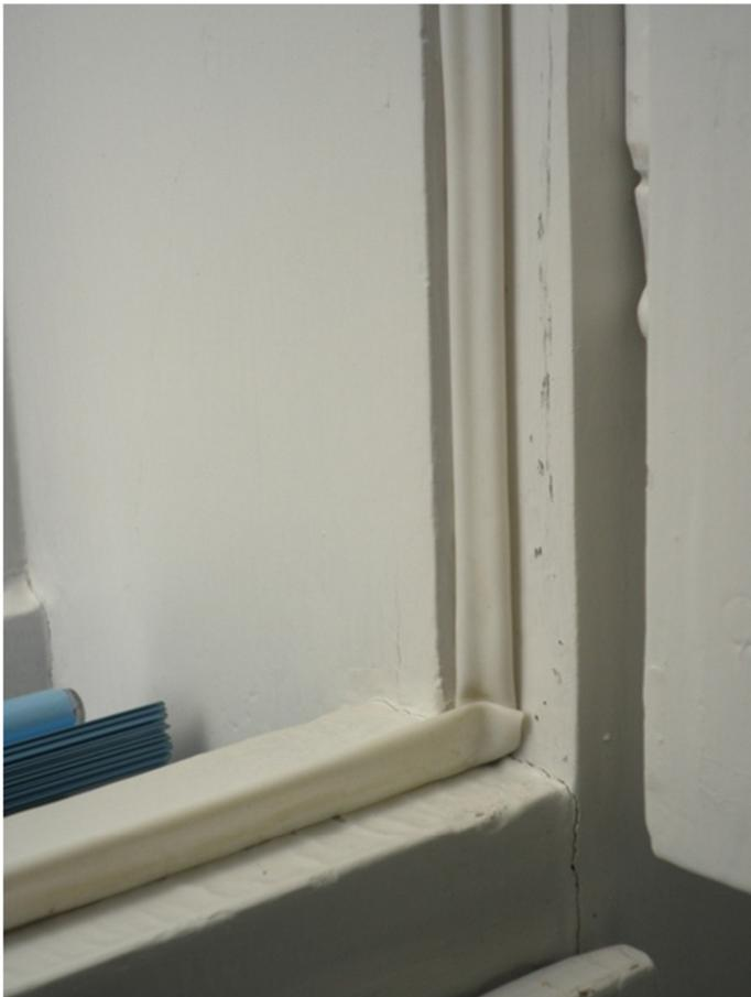
**Abbildung 19: sanierte innere Fensterlage mit eingelegter Dichtung (Autor)**
