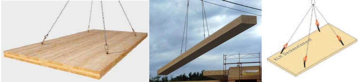
**Abbildung 6.23: vier Anschlagpunkte bei horizontalen Elementen**
