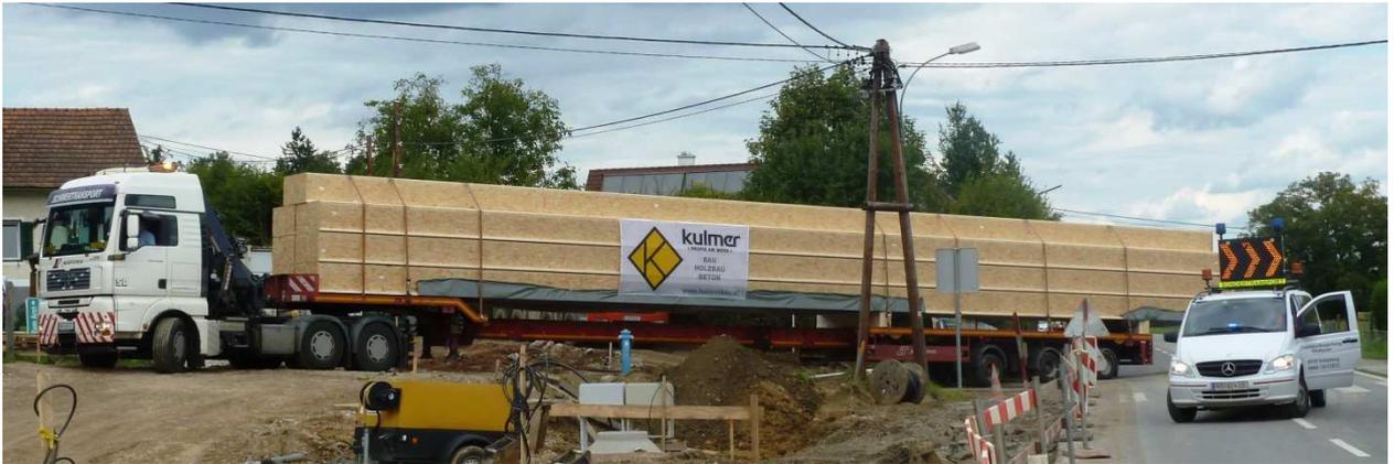
*Abbildung 6.12: Anlieferung von Kielsteg-Elementen der Firma Kulmer Holz-Leimbau GesmbH*
