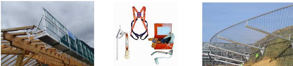
Abbildung 6.22: Absturzsicherungen – Schutzgerüst (links); pers. Schutzausrüstung (Mitte); Fangnetz (recht)
