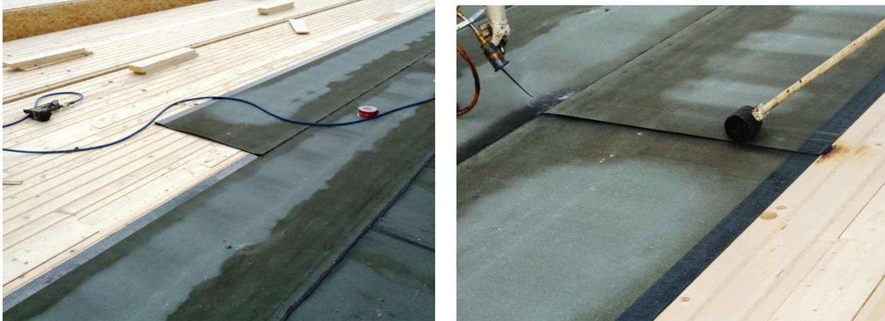
*Abbildung 6.31: Abdichtungsarbeiten unmittelbar nach der Montage*
