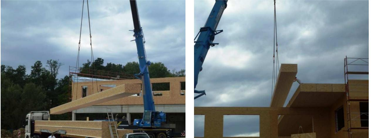
**Abbildung 6.29: Einheben von flächigen Holz-Elementen**
