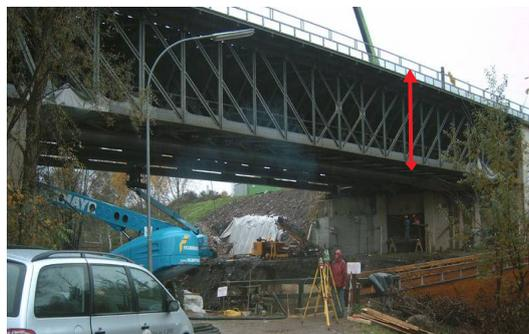
Abbildung 4.1: Messaufbau zur Detektion von vertikalen Bewegungen
