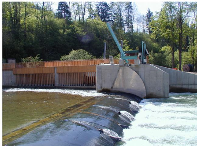
Abb. 69: Rechen bei der Wehranlage des KW Mürzzuschlag
