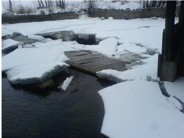
Abb. 64: Liegegebliebene Eisstöße im KW Hammerhof; UW des Wehres
