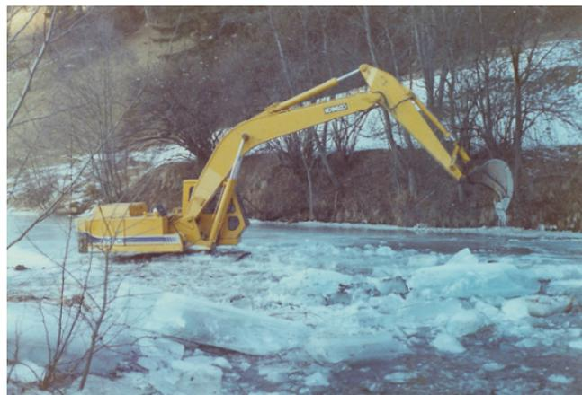
Abb. 60: Zerstörung eines Eisstoßes mit Hilfe eines Baggers im KW Hammerhof; Fließrichtung →
