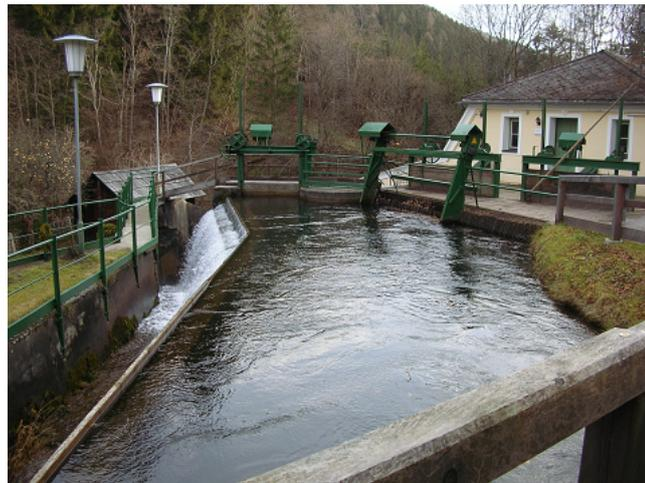
Abb. 10: Links - Überlauf; rechts - Einlauf Turbinen; Fließrichtung ↑
