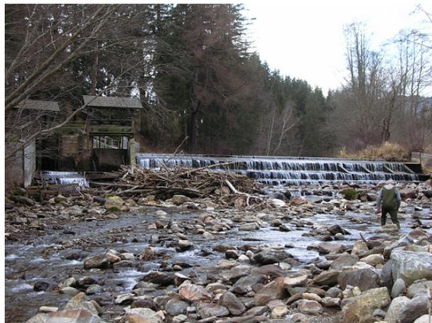
Abb. 65: Wehranlage des KW Hammerhof (mit Überlauf, Aufnahme vom 30.11.2009)
