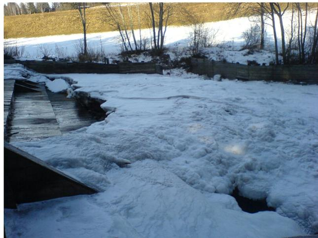
Abb. 59: Eisablagerungszone unterhalb der Wehranlage KW Hammerhof
