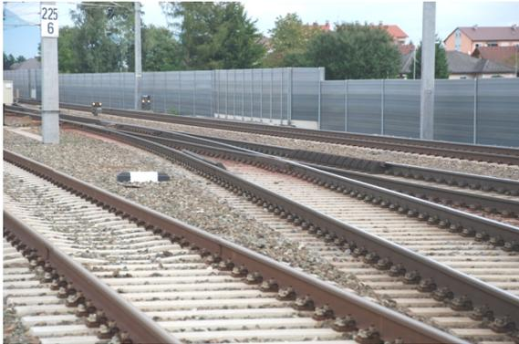
**Bild 5-3 Gleise mit Weiche im Bereich des mittleren Gleises**
