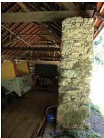
Abb. 375: Bruchstein-Mauerwerk, Raum 01
