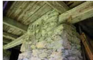
Abb. 365: Bruchstein-Mauerwerk,
