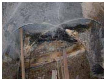
Abb. 397: Wasserschaden, Durchfeuchtung, Raum 01
