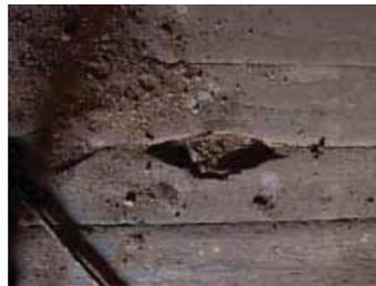
Abb. 400: Herausgebrochenes Stück Holz im Fußboden, Raum 13
