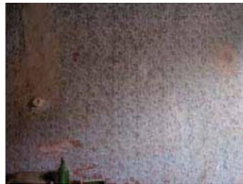
Abb. 312: verputztes MW, Muster mit Strukturwalze, Raum 06
