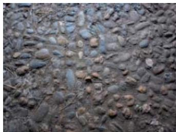
Abb. 251: Kugelstein-Pflasterung,
