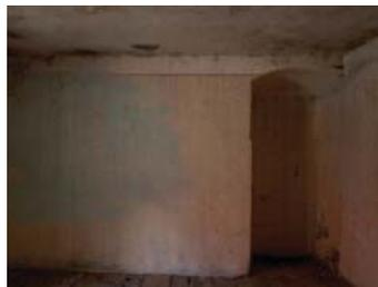
Abb. 310: verputztes MW, gestrichen, Muster mit Strukturwalze, Raum 15
