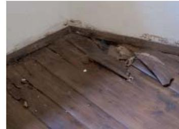
Abb. 383: Wasserschaden,
