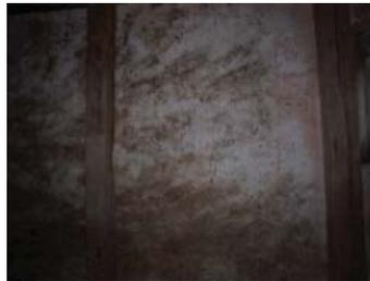
Abb. 308: verputztes MW, Spuren von Lagergut, Holzstützen, Raum 11
