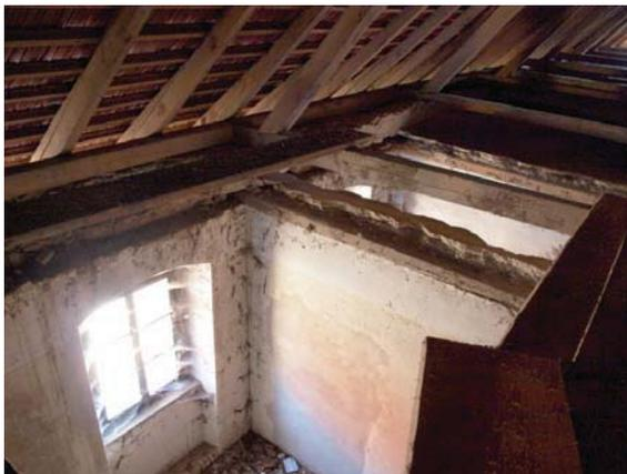
Abb. 246: Dachboden, eingestürzte Decke
