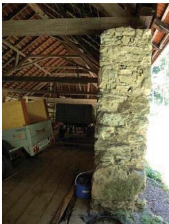
Abb. 375: Bruchstein-Mauerwerk, Raum 01
