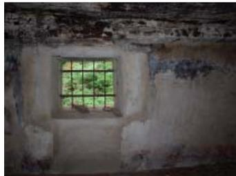
Abb. 407: Wasserschaden im oberen Bereich der Mauer und an der gesamten Decke, Raum 14
