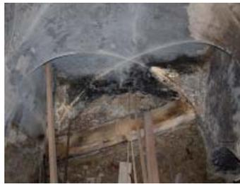
Abb. 397: Wasserschaden, Durchfeuchtung, Raum 01
