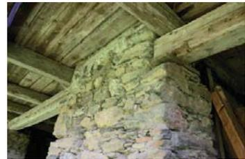
Abb. 365: Bruchstein-Mauerwerk,
