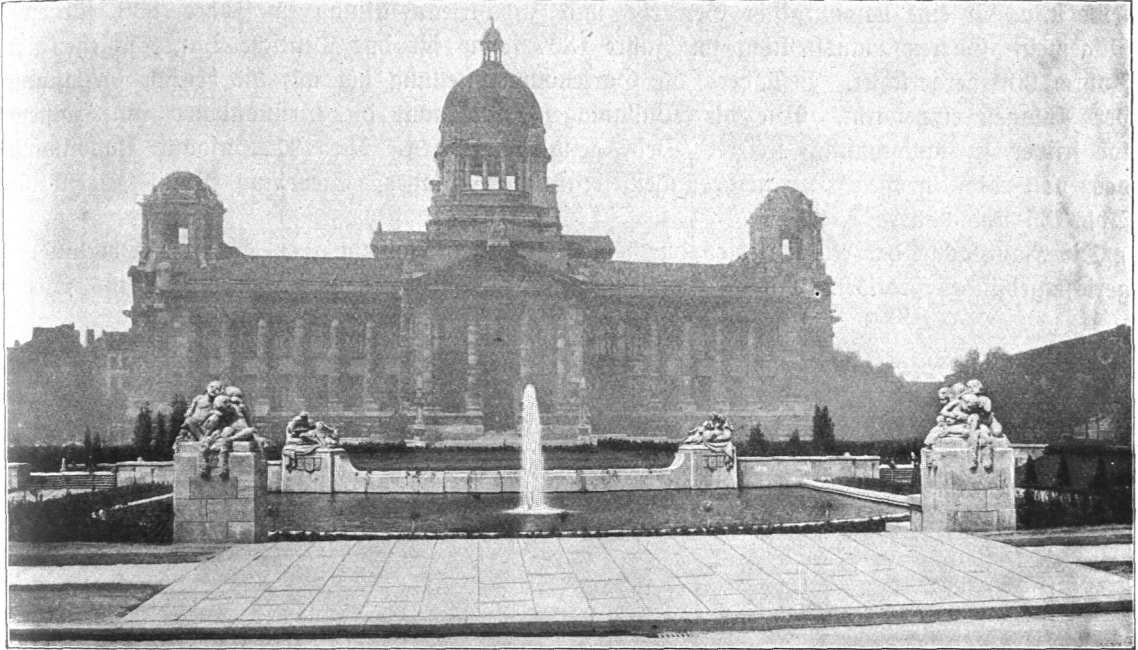
Abb. 436. Grünanlage Sieveking-Platz, Gesamtansicht.
