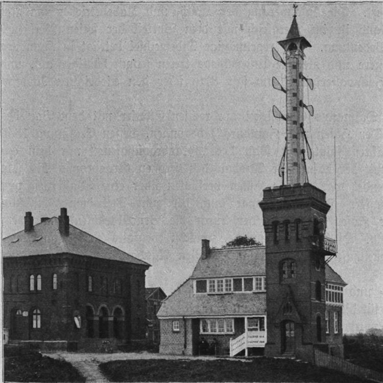
Abb. 68. Wasserstandsanzeiger bei Brunshausen.
