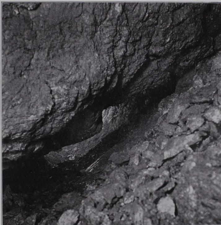
Fig. 34 Partie des Verhaues II von Norden. Durchblick unterhalb des Schachtes II zum erhaltenen alten Ort. (Hangend: die Bergfeste, liegend: größere Gesteinsblöcke und Grubenklein)
