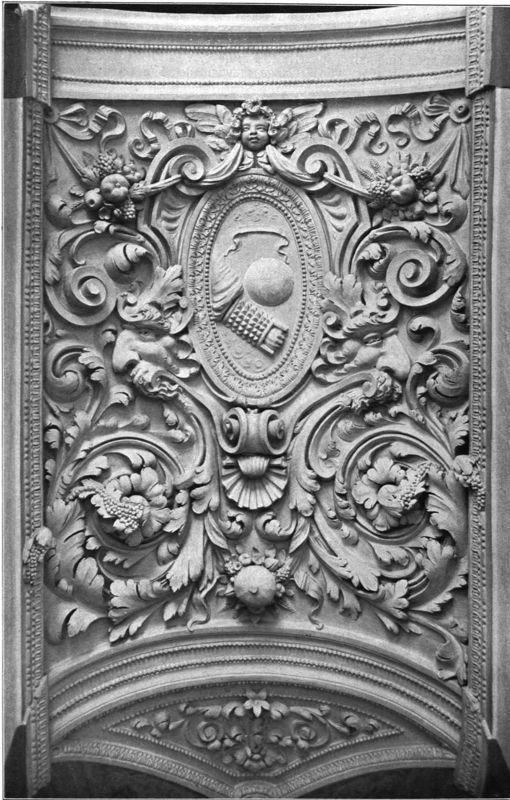
Fig. 48 Residenz, Deckendetail der Stiege im Südtrakt (S. 39)
