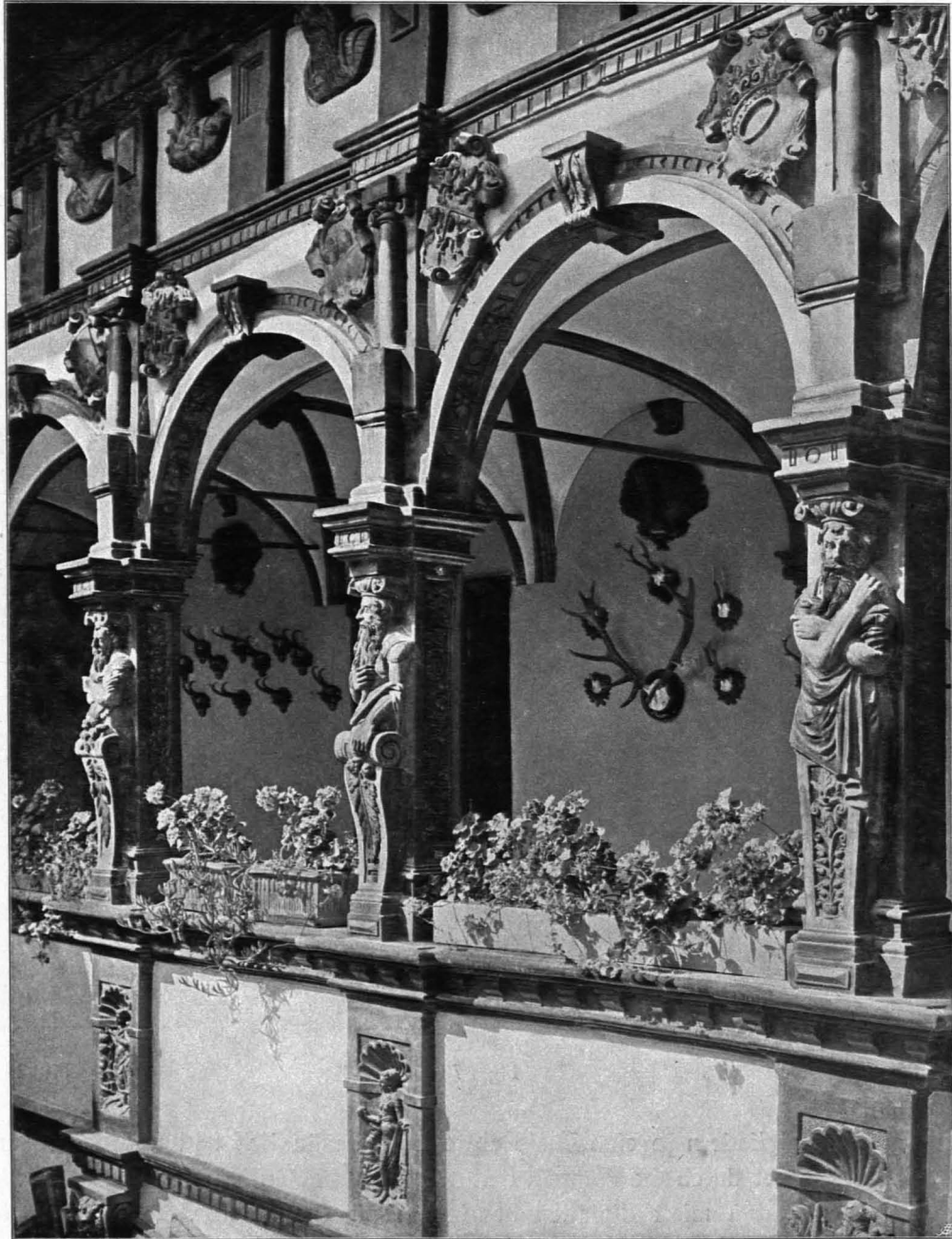
Fig. 38 Schallaburg, Arkadendetail an der Nordwand (S. 20)
