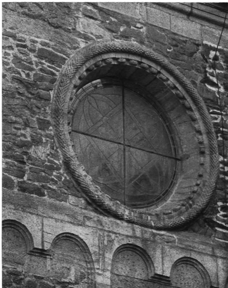
Abb. 228. Goslar, Neuwerkskirche, Chorquadrat, Nordwand, Rosenfenster.
