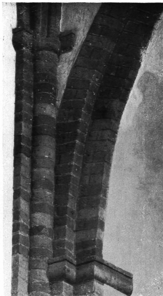
Abb. 23. Lehnin, Klosterkirche, Südostecke. Kämpfer für Rippen und Schildbogen.
