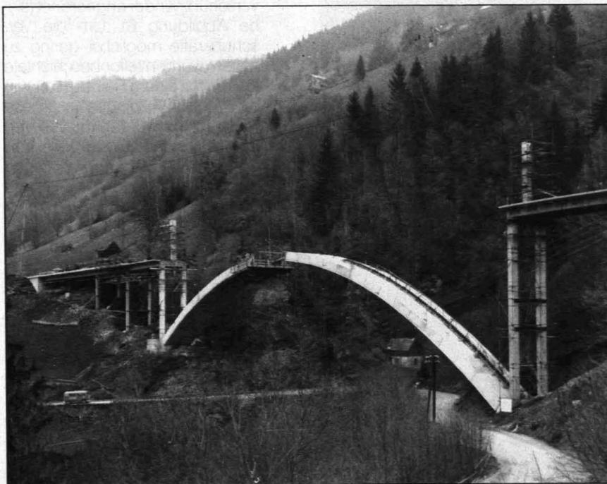
bau mit Abspannung, insbesondere mit der durch Messungen überprüften guten Übereinstimmung der hierfür entwickelten Berechnungsverfahren mit der Wirklichkeit des Bauens ausgehen konnte, ist die Herstellung von Bogentragwerken ebenfalls im freien Vorbau mit Abspannung.
