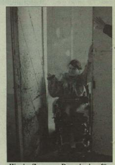
Wenig Zugang: Der einzige für Rollstuhlfahrer mögliche Zugang in die neue Technik führt über den Seiteneingang bei der Mensa. Breite des ersten Türflügels: 65 cm (schwer zu öffnen). Entriegelung für den zweiten Türflügel in 185 cm Höhe (gar nicht zu öffnen!).
