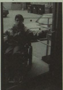
Fehlende Türöffner: Adaptierungsmaßnahmen von Altgebäuden sind aufgrund des Denkmalschutzes schwer durchzuführen. Dennoch können sie wie der Lift in der Alten Technik voll rollstuhlgerecht ausgeführt werden. Leider ist jedoch der Zugang ins Gebäude trotz der hofseitigen Rampe nicht rollstuhlgerecht. Hier fehlt ein automatischer Türöffner.
