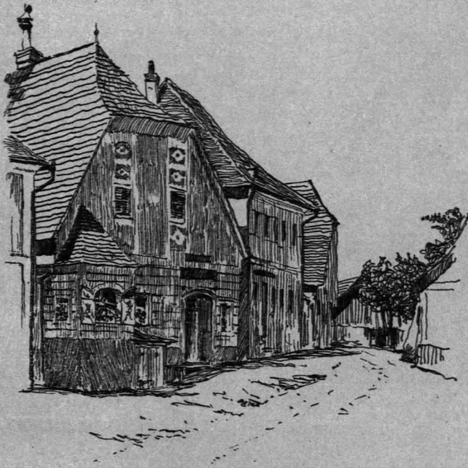
Strasse aus St. Peter
