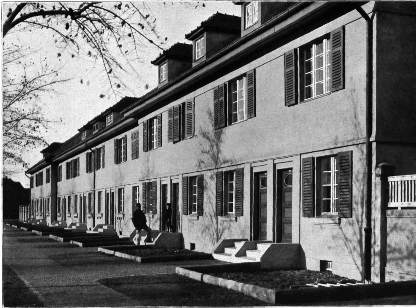
387 / BERLIN-OBERSCHÖNEWEIDE Zeppelin-Straße Settlement Arch.: Peter Behrens
