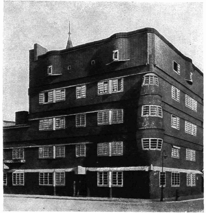
270 / AMSTERDAM Beispiel moderner Ausschweifungen Flats in "modern" style Arch.: M. de Klerk
